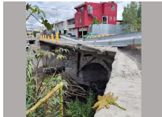
Figura 3.162 Fotografía, puente entre Huitel y Presas, tomada por Lilian Nallely Velázquez Cervantes, 16 de octubre de 2023, San Isidro Presas, archivo personal.
