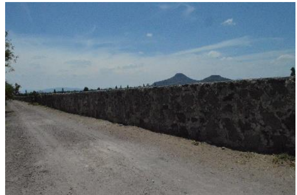
Figura 3.137 Fotografía, presa nueva, la cortina fue construida con roca basáltica pegada con mortero, tomada por Lilian Nallely Velázquez Cervantes, 23 de abril de 2017, comunidad de San Isidro Presas, archivo personal.
