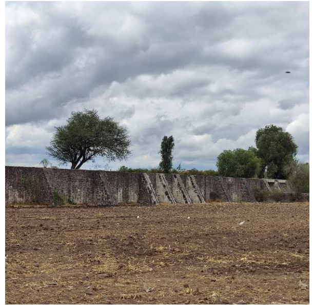
Figura 3.141 Fotografía, contrafuertes de la cortina de la presa nueva, tomada por Lilian Nallely Velázquez Cervantes, 16 de octubre de 2023, comunidad de San Isidro Presas, archivo personal.
