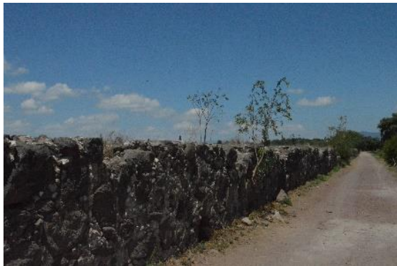
Figura 3.136 Fotografía, presa nueva, los pobladores de Tezontepec han restaurado la presa por sus medios en áreas dañadas, tomada por Lilian Nallely Velázquez Cervantes, 23 de abril de 2017, comunidad de San Isidro Presas, archivo personal.
