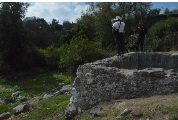
Figura 3.163 Fotografía, pozo del Detri, ubicado en la colonia Presas, sobre la calle Venustiano Carranza. Actualmente se encuentra en desuso. Tomada por Lilian Nallely Velázquez Cervantes, 23 de abril de 2017, San Isidro Presas, archivo personal.
