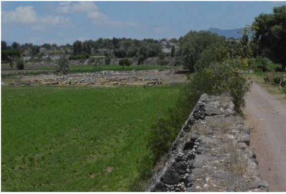
Figura 3.134 Fotografía, cortina de la presa nueva, fue utilizada para regar las tierras de la hacienda de Tlahuelilpan. Tomada por Lilian Nallely Velázquez Cervantes, 23 de abril de 2017, comunidad de San Isidro Presas, archivo personal.
