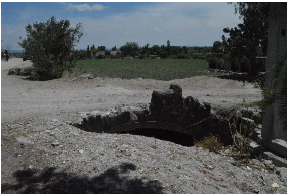
Figura 3.146 Fotografía, puente ciego, se localiza por debajo de un camino de terracería, ha perdido componentes arquitectónicos, tomada por Lilian Nallely Velázquez Cervantes, 23 de marzo de 2017, colonia Lázaro Cárdenas, archivo personal.
