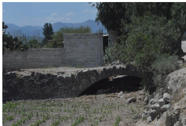
Figura 3.20 Fotografía. Arco de la infraestructura de la presa. La estructura se ha ido cubriendo con la tierra acumulada proveniente del riego de agua negra. Tomada por Lilian Nallely Velázquez Cervantes, 23 de abril de 2017, Presas, archivo personal.
