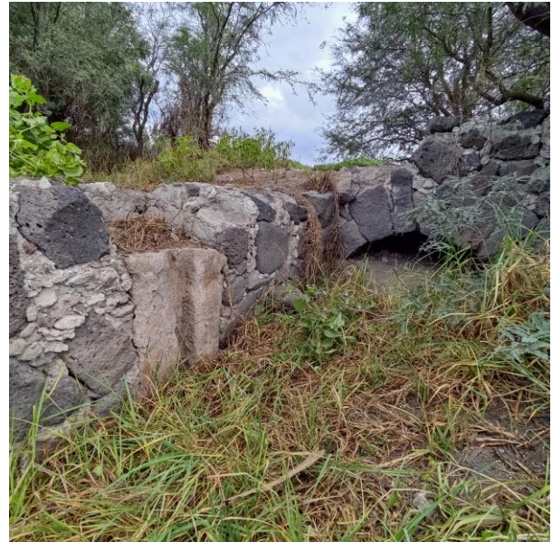
Figura 3.156 Fotografía, tercer arco de la herradura, se observa el canal en la roca por donde se colocaba la compuerta para distribuir el agua, tomada por Lilian Nallely Velázquez Cervantes, 16 de octubre de 2023, cerro del Xicuco, archivo personal.
