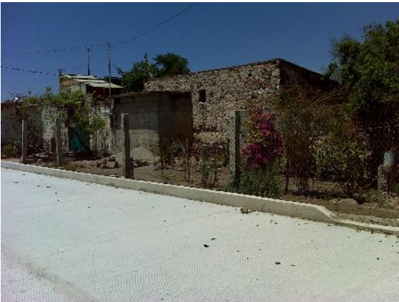
Figura 3.188 Fotografía, casa de piedra de la familia Mota, ubicada sobre la Av. Zanja Colorada, tomada por Lilian Nallely Velázquez Cervantes, 4 de abril de 2017, el Tinaco, archivo personal.
