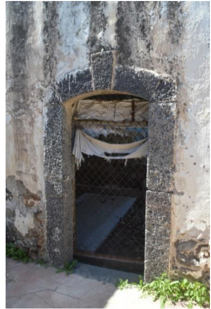
Figura 3.194 Fotografía, casa de piedra, algunas puertas cuentan con dinteles y jambas de piedra volcánica labrada, tomada por Lilian Nallely Velázquez Cervantes, 16 de julio de 2017, el Tinaco, archivo personal.
