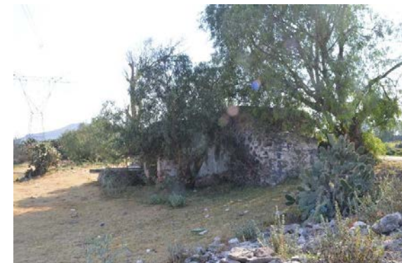
Figura 3.132 Fotografía, caseta de agua, formó parte del sistema hidráulico, aquí se repartía el agua, los habitantes dicen que adentro se quedaban los canaletos. Tomada por Lilian Nallely Velázquez Cervantes, 3 de enero de 2018, paraje el Gavillero, archivo personal.
