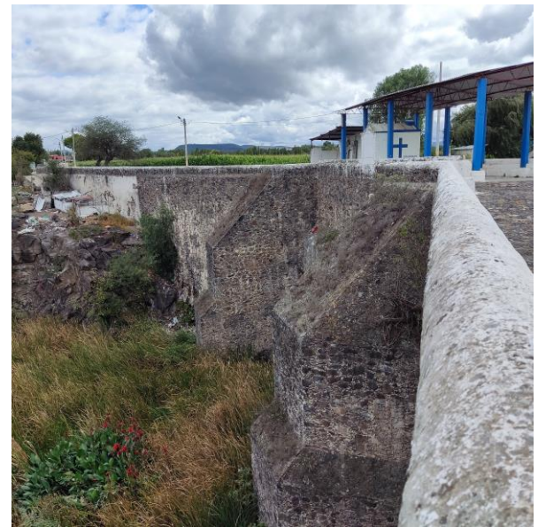
Figura 3.143 Fotografía, contrafuertes de la cortina de la presa nueva, en la actualidad los habitantes han construido una capilla en la parte superior de la cortina, tomada por Lilian Nallely Velázquez Cervantes, 16 de octubre de 2023, comunidad de San Isidro Presas, archivo personal.
