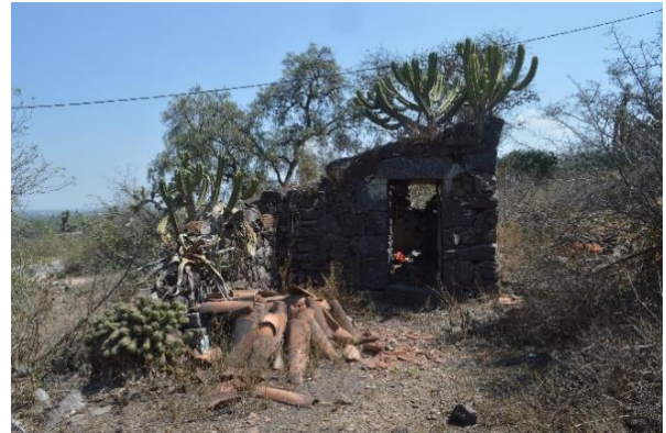
Figura 3.22 Fotografía. Casa de piedra con techo de teja. Tomada por Lilian Nallely Velázquez Cervantes, 24 de febrero de 2018, San Isidro el Tanque, archivo personal.
