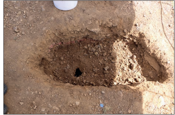
Figura 22. Fosa perfilada en donde es posible apreciar orificio y bóveda.
